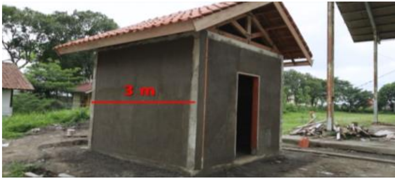
Gambar 42. Luas Maksimum Dinding dan Jarak Maksimum Antar Kolom
