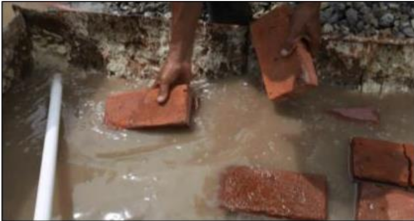
Gambar 15. Perendaman Batu Bata Sebelum Dipasang
