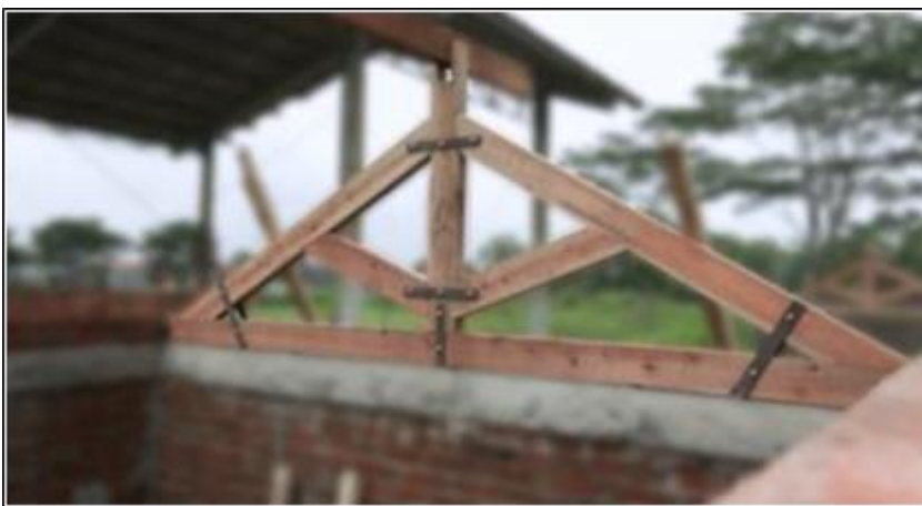
Gambar 28. Kuda-kuda Kayu Dengan Pengikat Plat Baja
