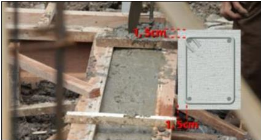
Gambar 19. Balok Pengikat/ Sloof
