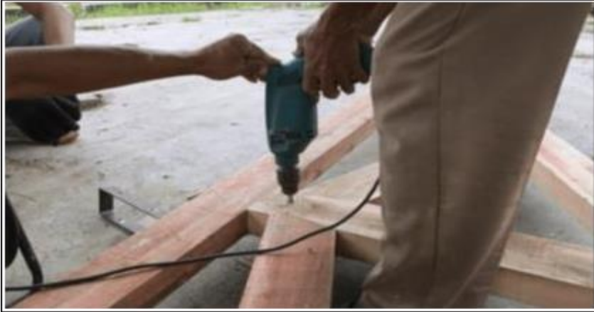
Gambar 31. Pemasangan Plat Baja Pada Kuda-Kuda Kayu Menggunakan Bor Listrik
