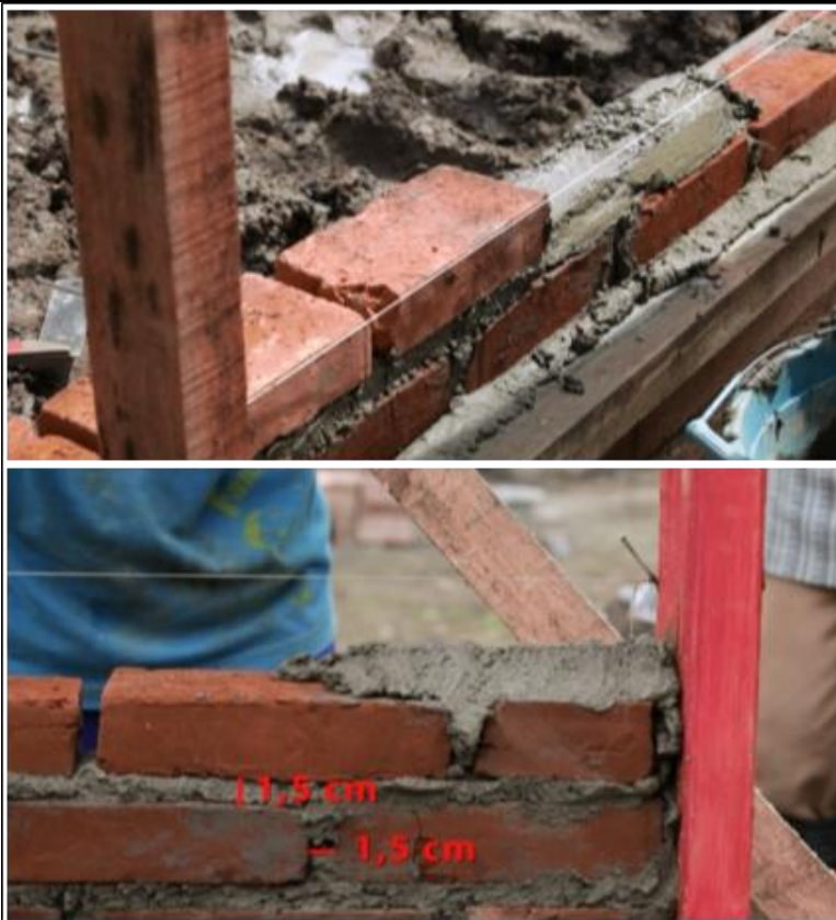
Gambar 41. Proses Pemasangan Batu Bata Untuk Dinding
