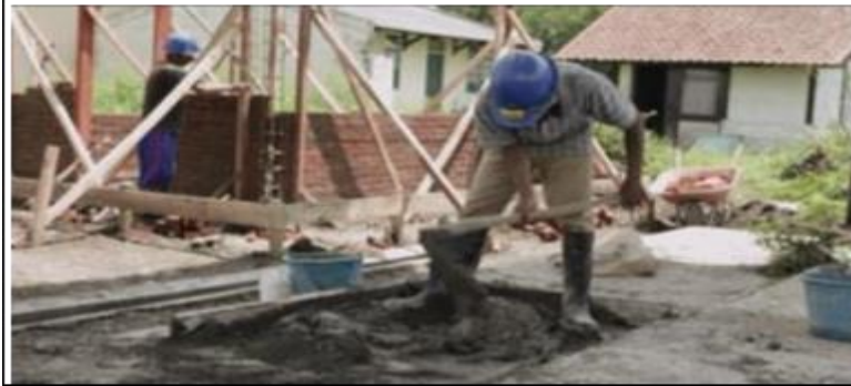
Gambar 8. Proses Pencampuran Mortar
